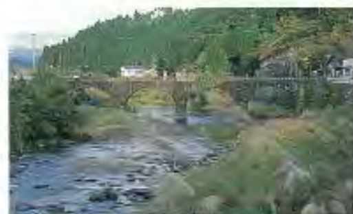
四連の宮ヶ原橋（大正11年竣工）
