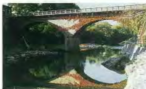
二連の寄口橋（大正9年竣工）
